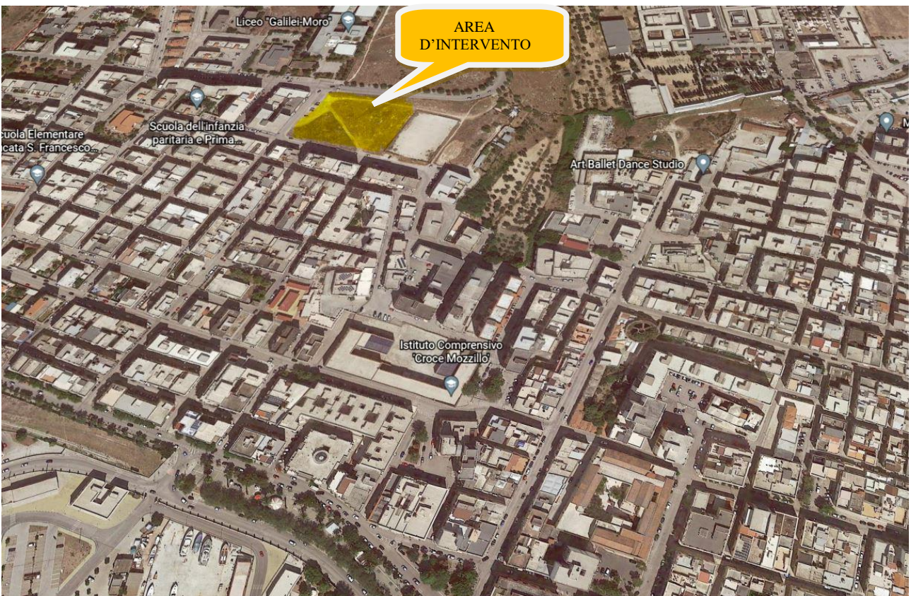
Vista aerea - zona d'intervento
